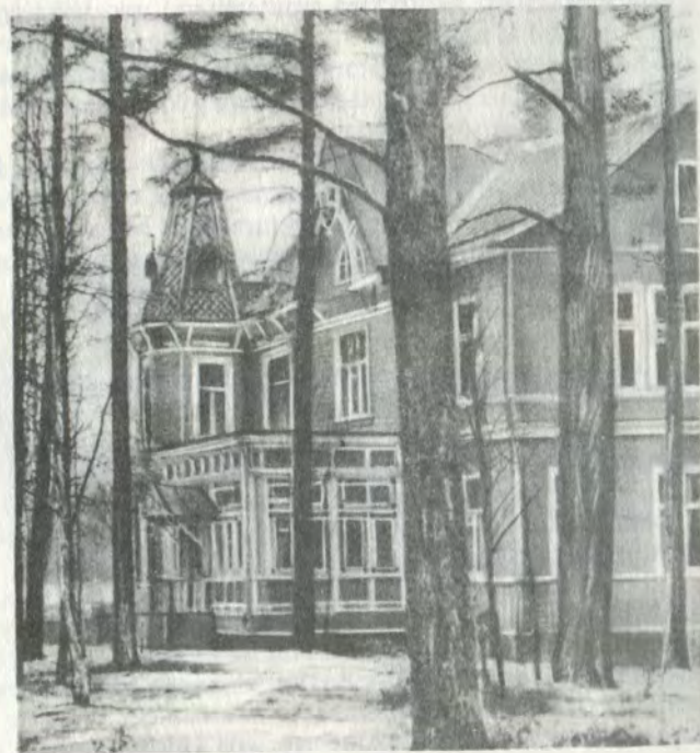
Современный вид бывшей дачи Уотинена. Фотография 1962 года.
