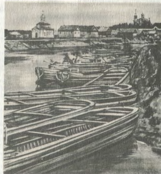
На Тихвинском канале.
